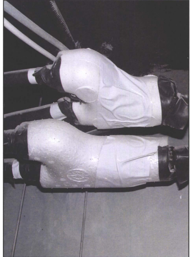
Şekil 6.149. ISI GERİ KAZANIM SİSTEMİ GAZ DAĞITIM KUTULARI VE REFNET (BRANŞMAN KİTLERİ)
