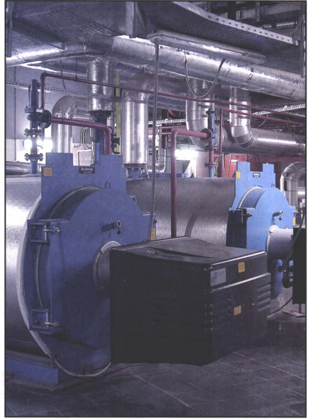
Şekil 6.33B. Kanyon OFİSLER ISITMA KAZANLARI
