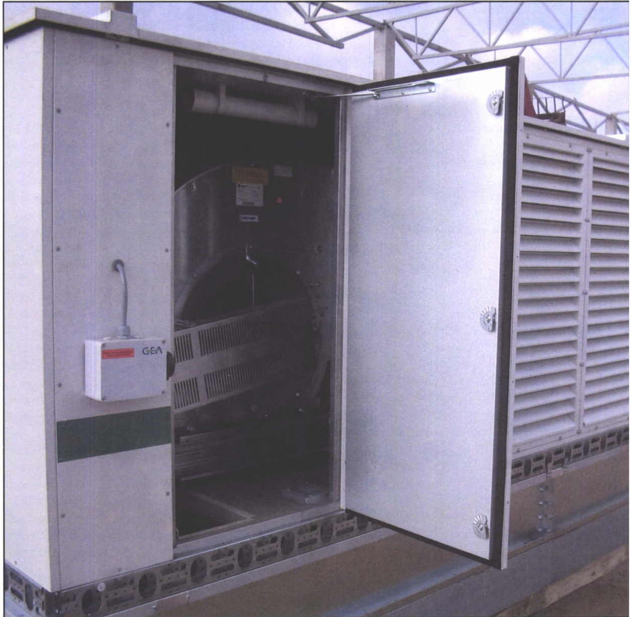
Şekil 9.3. HARİCİ TİP KARIŞIM HAVALI KLİMA SANTRALİ - 20.000 m 3 /h (Enerji kaybını engellemek için kanal ve serpantin bağlantıları alttan)
