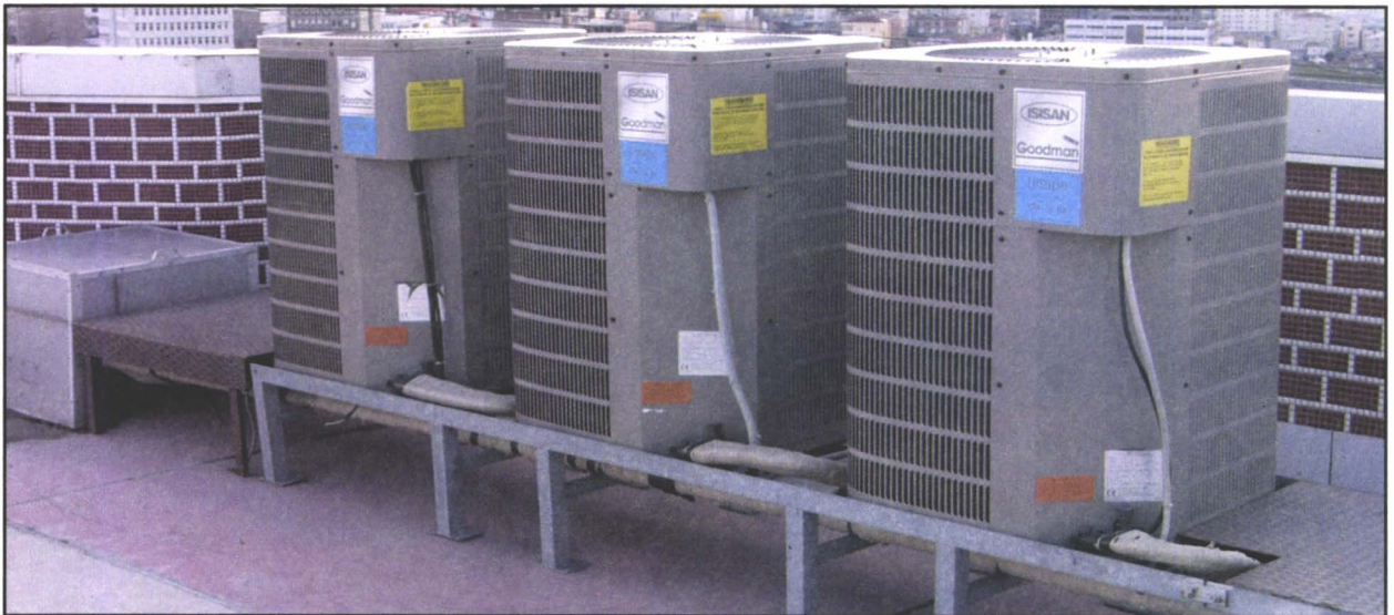
Şekil 6.52. Yüceler Mağazası DIŞ ÜNİTELER
