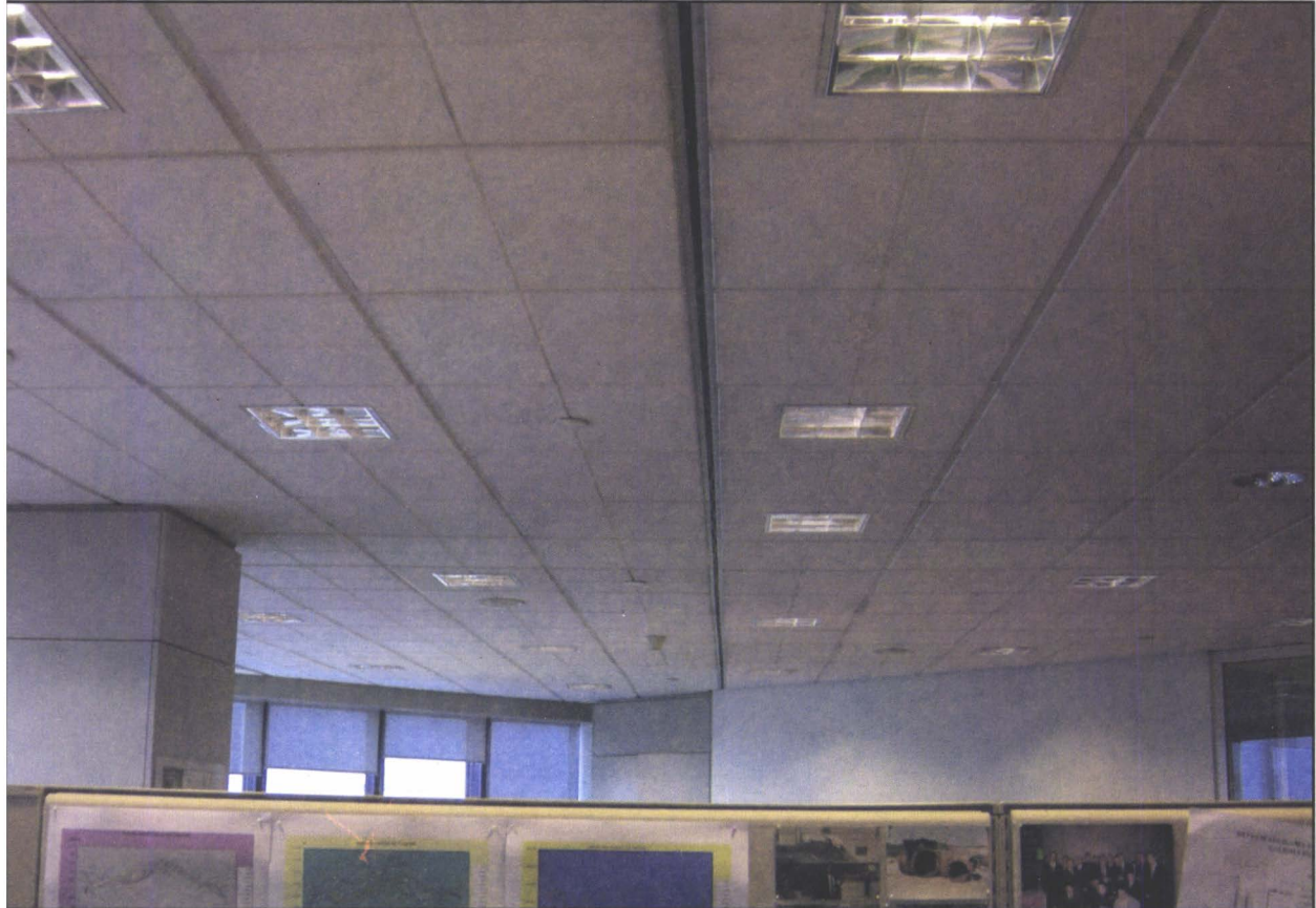
Şekil 6.6. Sabancı Center OFİSLER SLOT DİFÜZÖRLER
