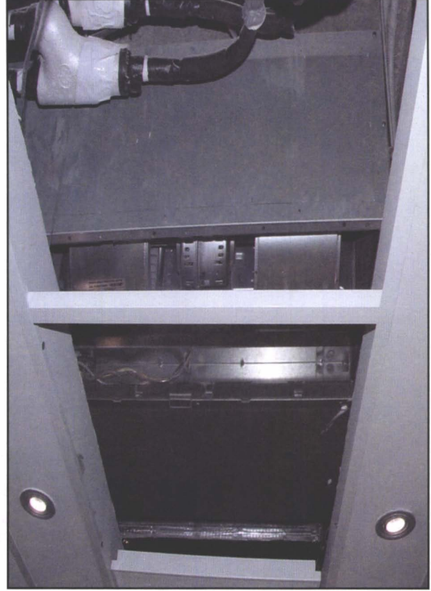
Şekil 6.148. GİZLİ TAVAN TİPİ İÇ ÜNİTELER
