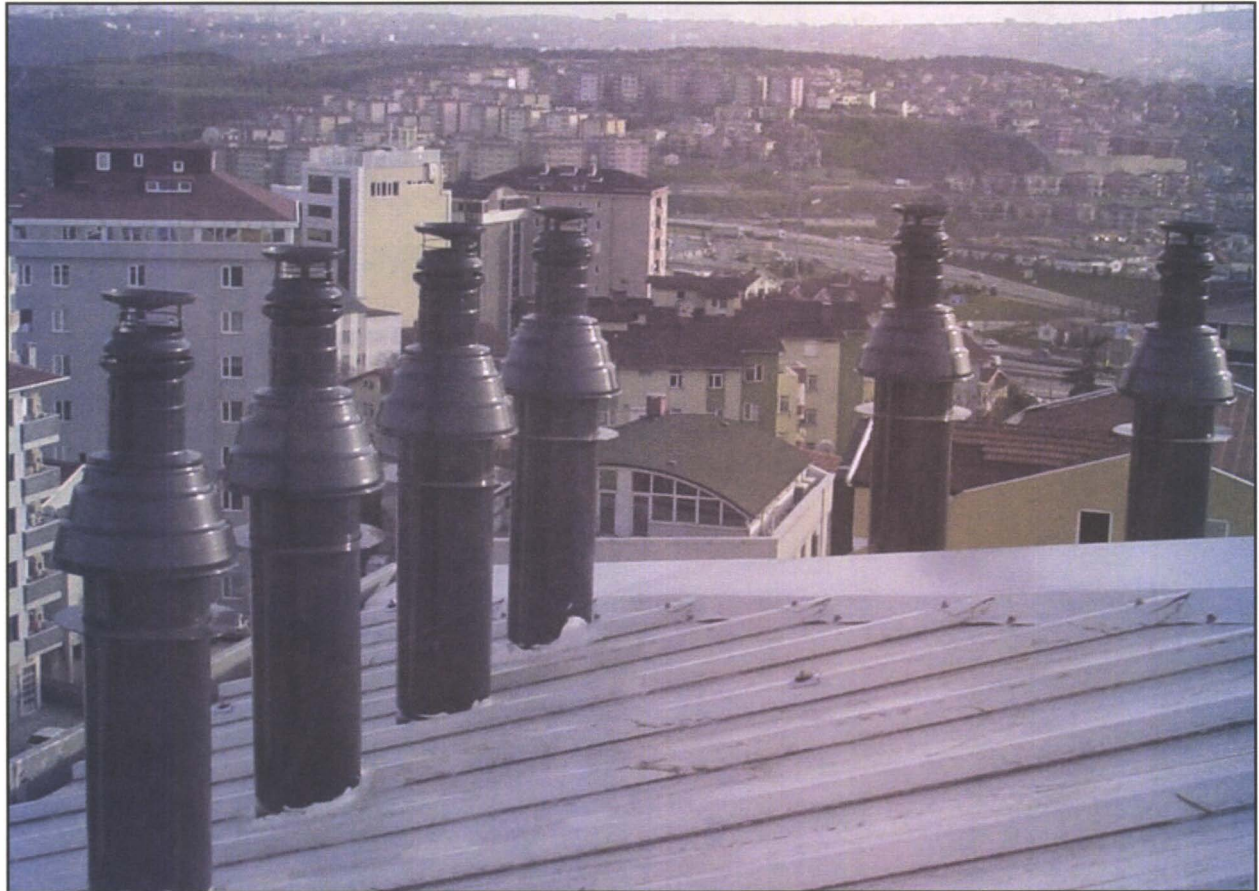
Şekil 6.100B. HERMETİK BACA SİSTEMİ ÇATI UYGULAMASI
