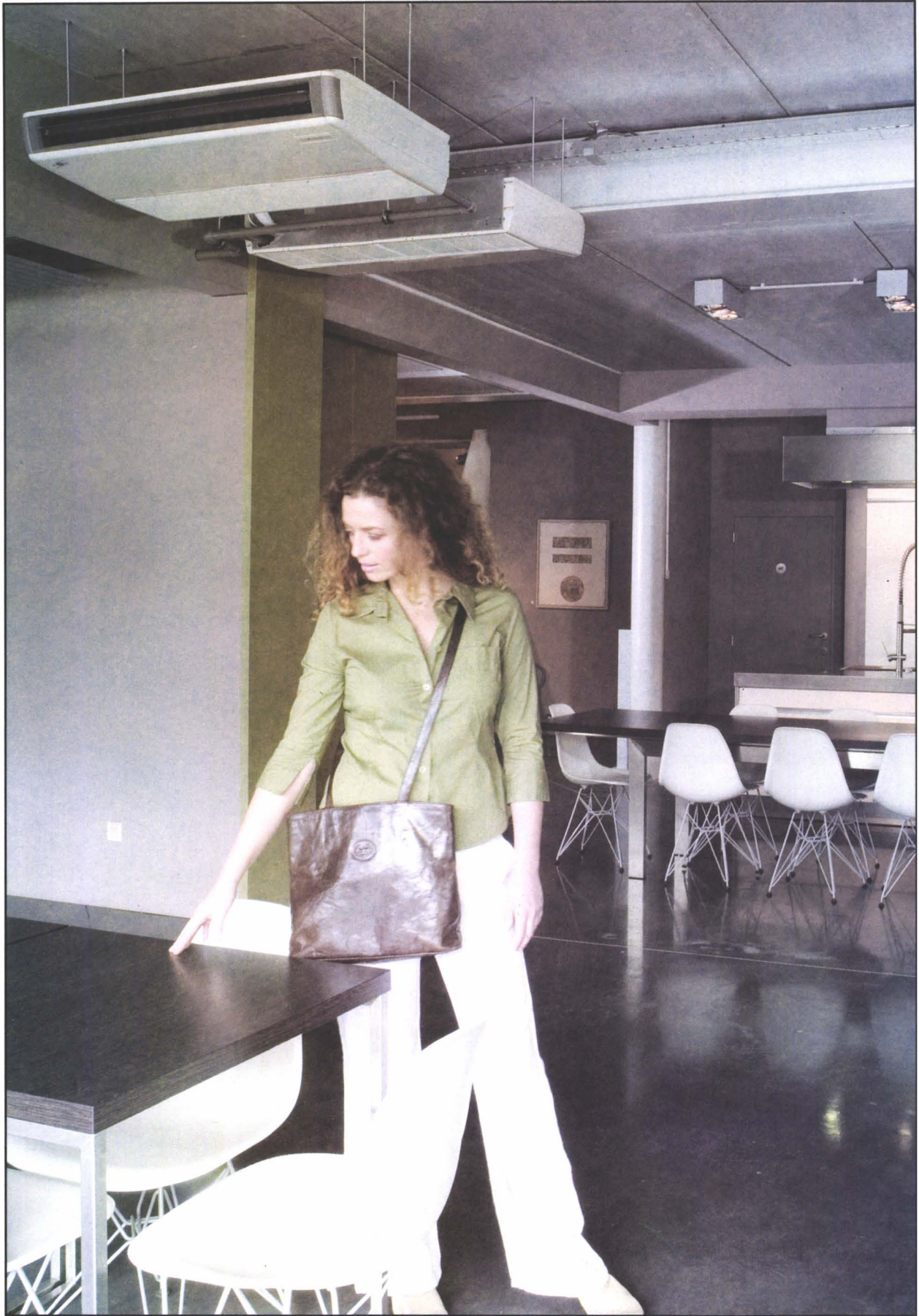
Şekil 6.57F. VRV SİSTEM TAVAN TİPİ İÇ ÜNİTE UYGULAMA ÖRNEĞİ
