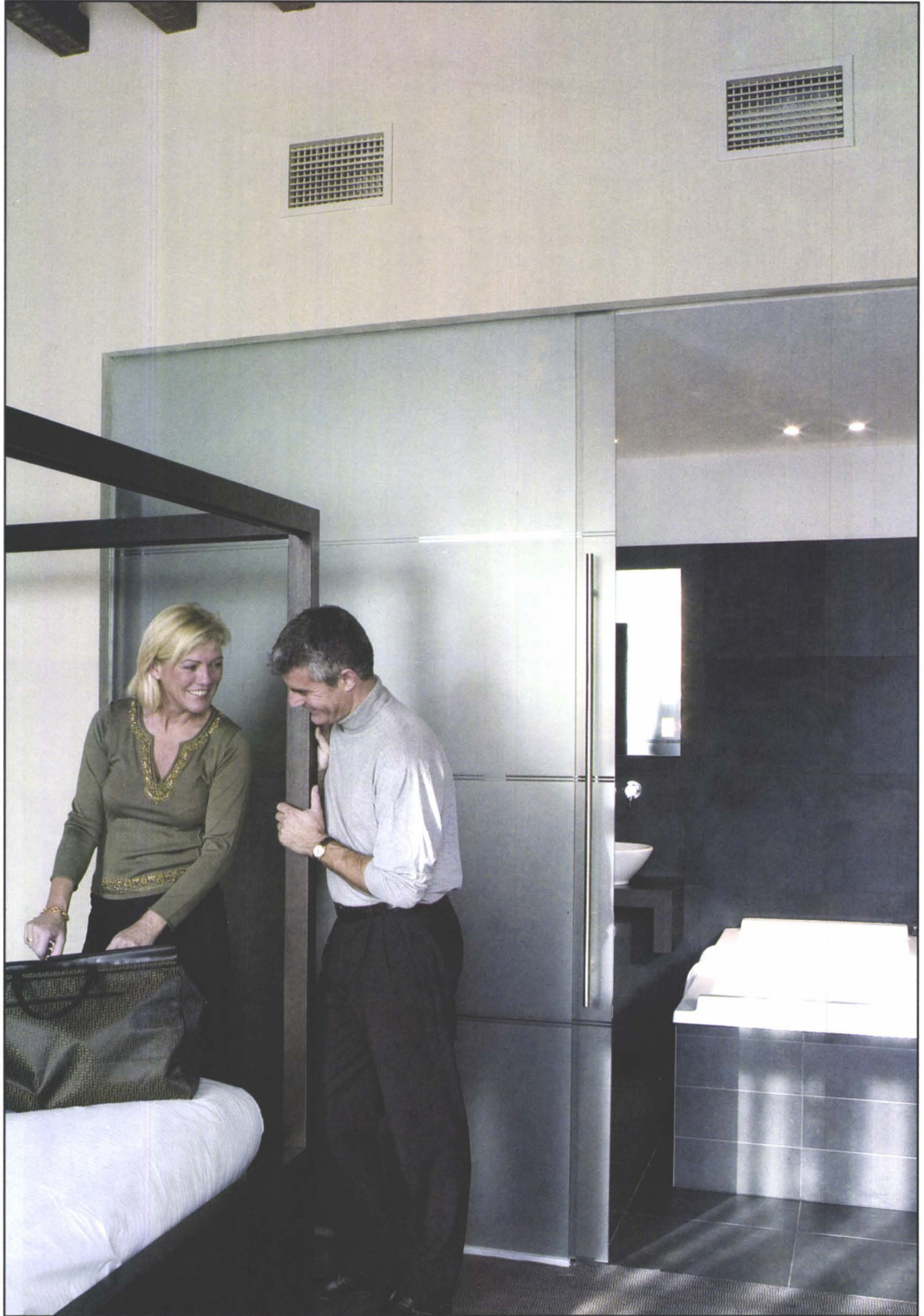
Şekil 6.57E. VRV SİSTEM GİZLİ TAVAN TİPİ (ORTA STATİK BASINÇLI) İÇ ÜNİTE UYGULAMA ÖRNEĞİ
