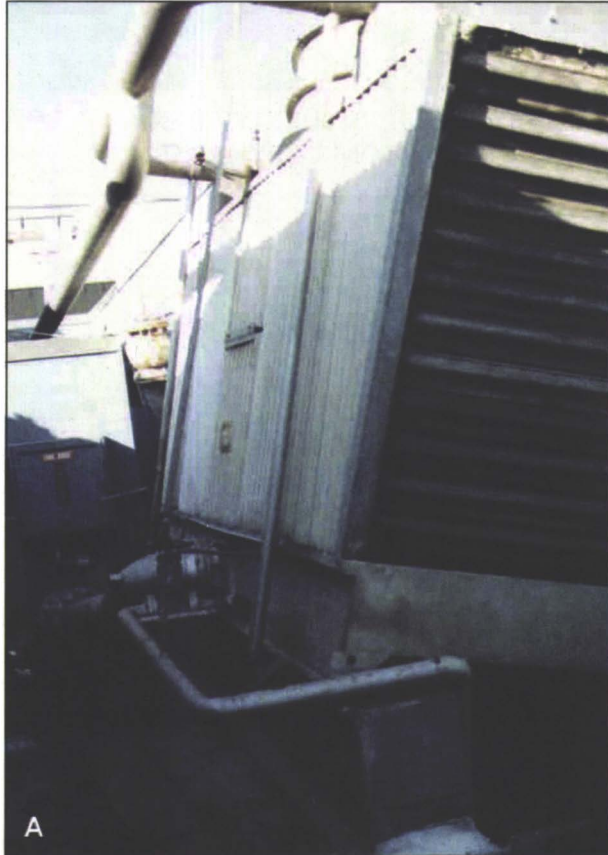
Şekil 12.6. DEPREM KORUMASI YAPILMAMIŞ TESİSAT DONANIMLARINDA HASAR OLUŞUMU
