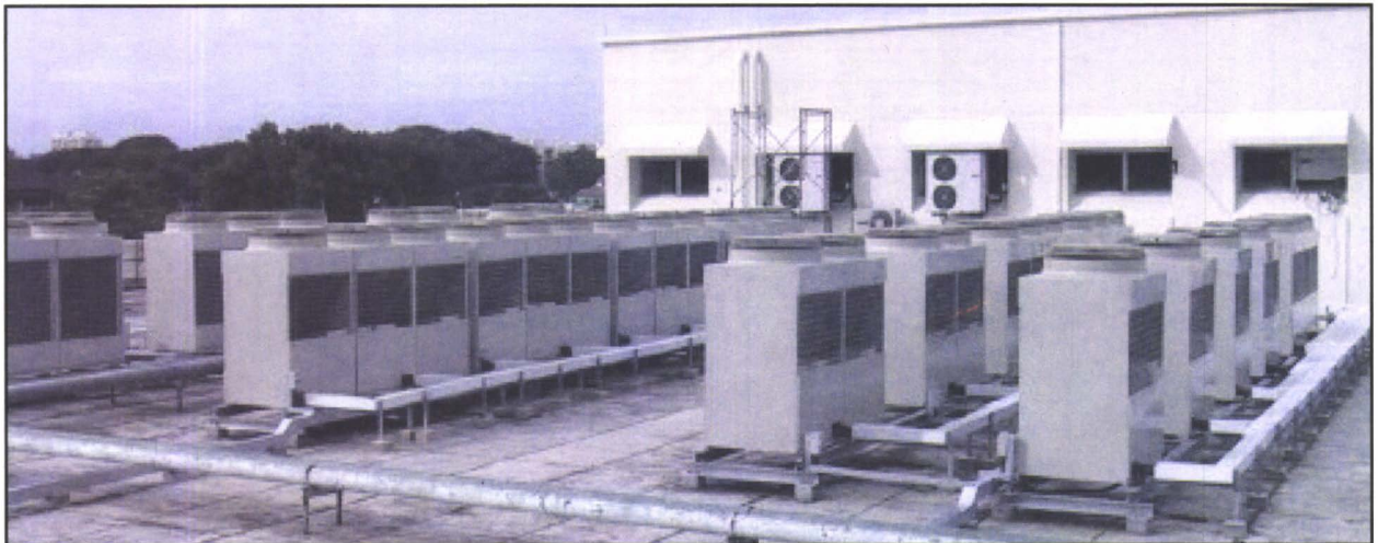
Şekil 6.65. ZEMİNDE VRV DIŞ ÜNİTE YERLEŞİM ÖRNEĞİ
