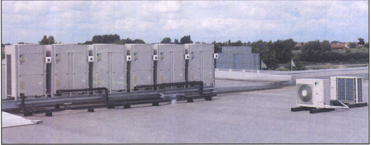
Şekil 6.64. ÇATIDA VRV DIŞ ÜNİTE YERLEŞİM ÖRNEĞİ
