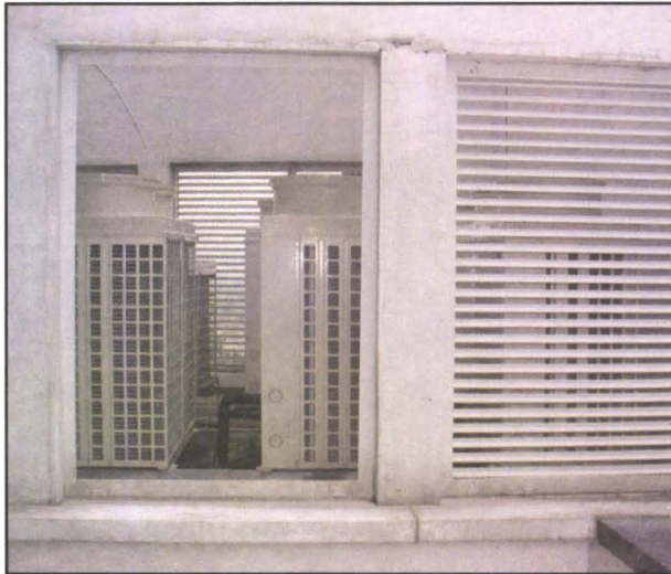
Şekil 6.146. Metrocity Residence HEAT PUMP VRV DIŞ ÜNİTELERİ (ÇATIDA)
