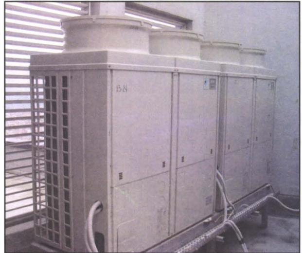
Şekil 6.146. Metrocity Residence HEAT PUMP VRV DIŞ ÜNİTELERİ (ÇATIDA)
