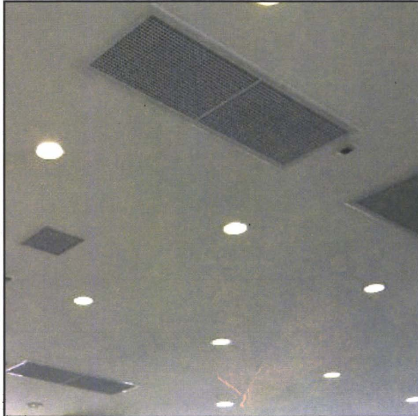
Şekil 6.80. GİZLİ TAVAN TİPİ İÇ ÜNİTE UYGULAMASI
