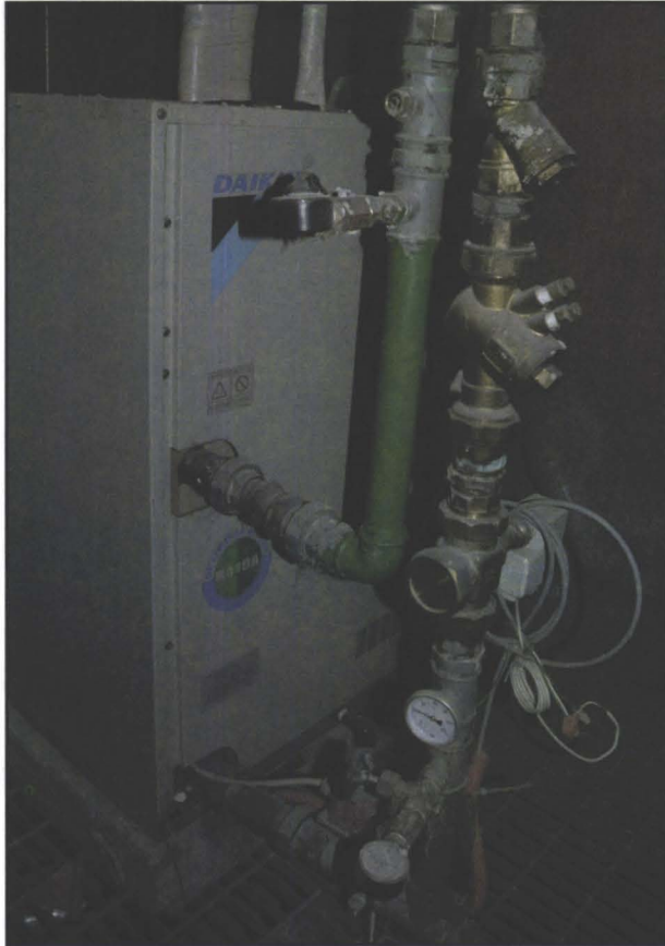
Şekil 6.95. Koza Plaza SU SOĞUTMALI VRV SİSTEM-DIŞ ÜNİTELER
