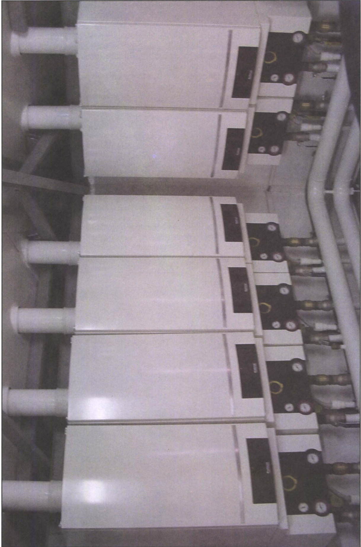
Şekil 6.100A. MERKEZİ YOĞUŞMALI KASKAD SİSTEM UYGULAMASI (HERMETİK BACA BAĞLANTISI) - ÇATI ISI MERKEZİ
