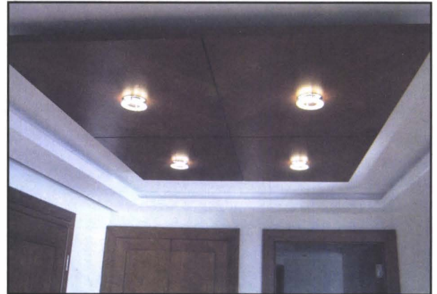
Şekil 6.47. GİZLİ TAVAN TİPİ İÇ ÜNİTEYE SERVİS HİZMETİ, YERE MONTAJA GÖRE DAHA ZOR YAPILIR. Dekorasyonda kapak detayları, servis için kolay yapılabilen boyutlarda olmalı ve kolay sökülüp takılabilmelidir.
