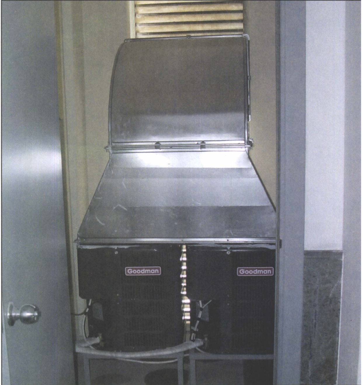
Şekil 6.118. Trio Konutları DIŞ ÜNİTE YERLEŞİMİ
