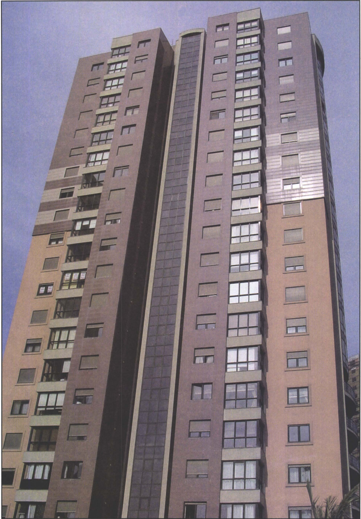
Şekil 6.116. Trio Konutları HAVA KANALLI SPLİT + STATİK ISITMA UYGULAMASI
