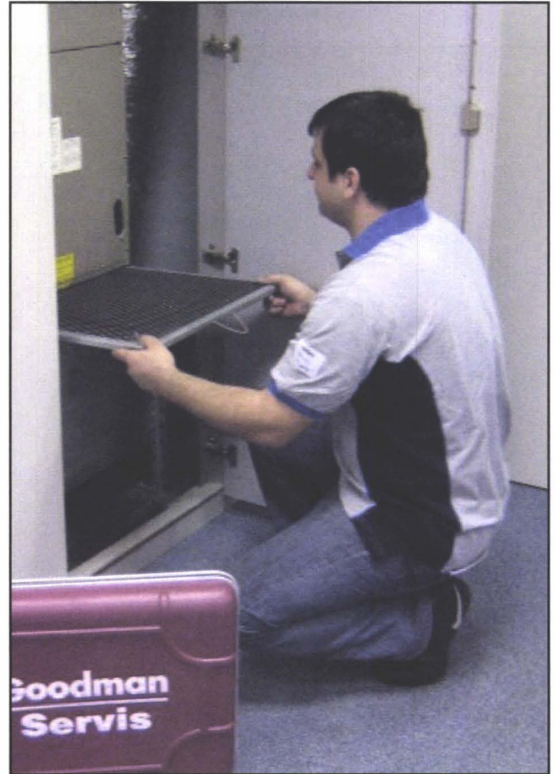
Şekil 6.46. DÖŞEMEYE MONTE EDİLEN SPLIT KLİMA İÇ ÜNİTELERİNDE BASİT VE HIZLI FİLTRE TEMİZLİĞİ YAPILABİLİR.
