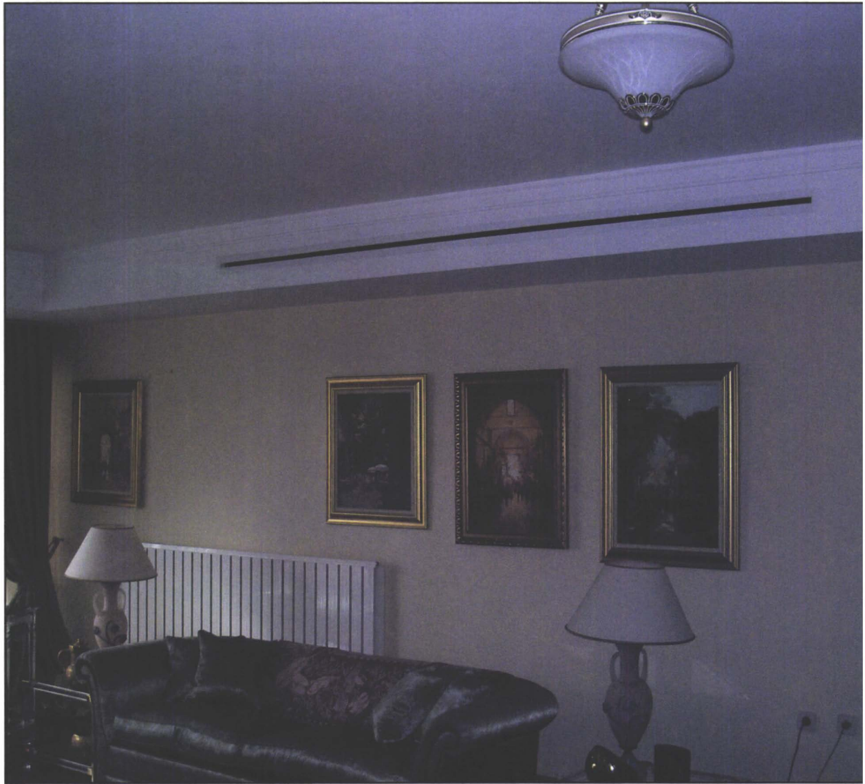
Şekil 6.120. Trio Konutları DAİRE - SLOT DİFÜZÖR
