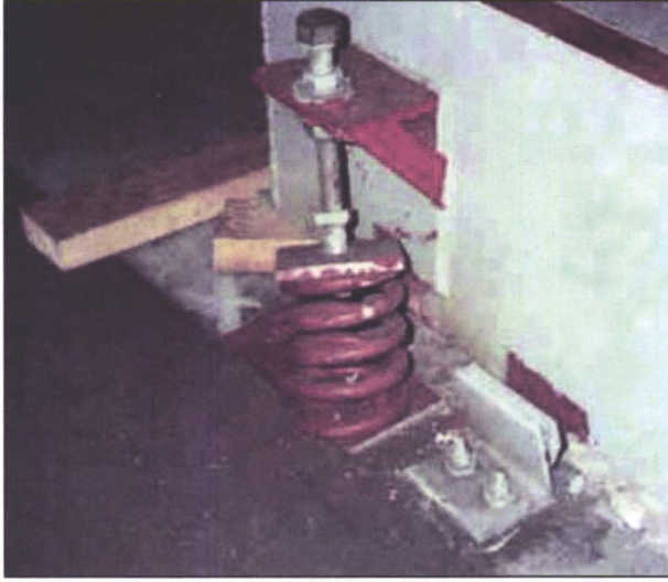
Şekil 12.9. AÇIK İZOLATÖRLERLE BİRLİKTE KULLANILMAK ÜZERE SEÇİLMİŞ ANCAK GEREĞİNDEN KÜÇÜK BOYUTLANDIRILMIŞ SİSMİK SINIRLANDIRICILAR SEBEBİYLE POMPA ŞASİSİNDE HASAR OLUŞUMU
