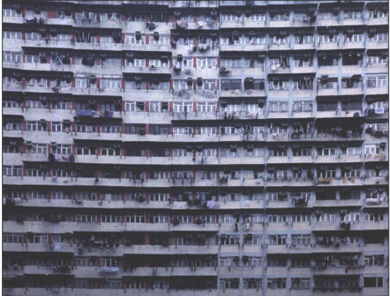
Şekil 6.55. CEPHEDEKİ DIŞ ÜNİTELERİN OLUŞTURDUĞU GÖRÜNTÜ KİRLİLİĞİ
