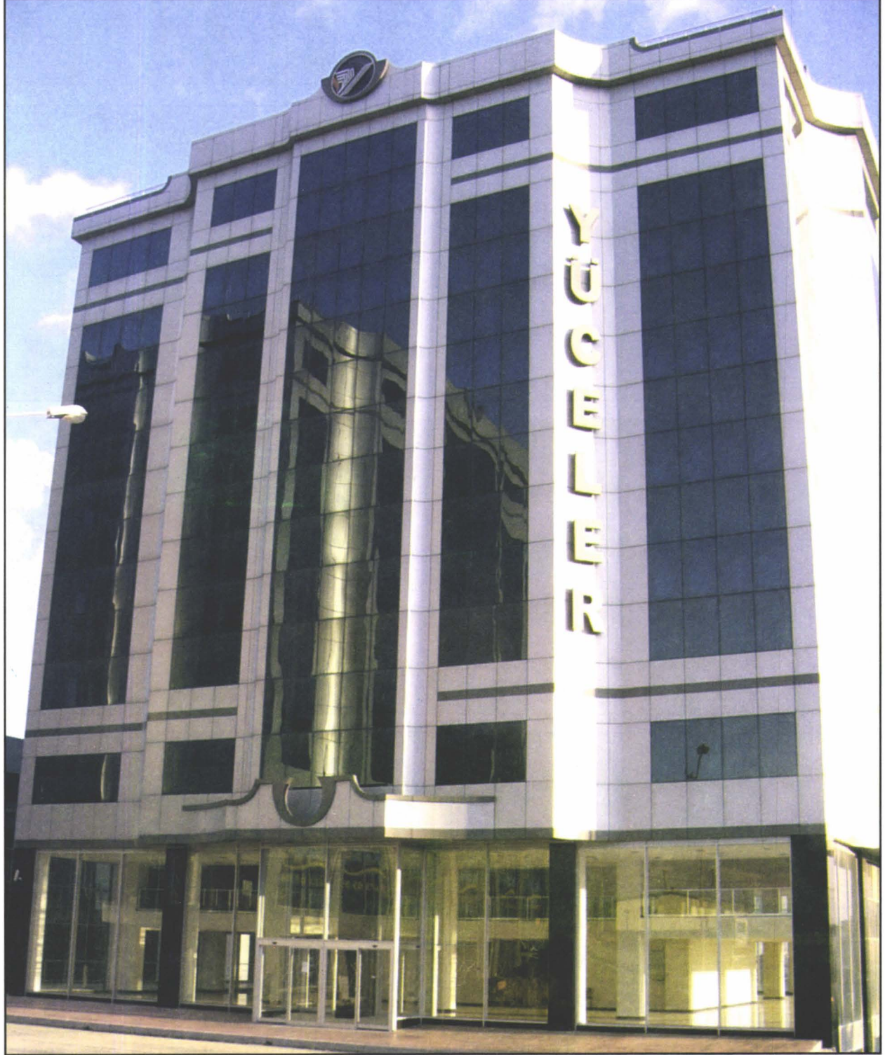
Şekil 6.48. Yüceler Mağazası HAVA KANALLI SPLİT KLİMA UYGULAMASI
