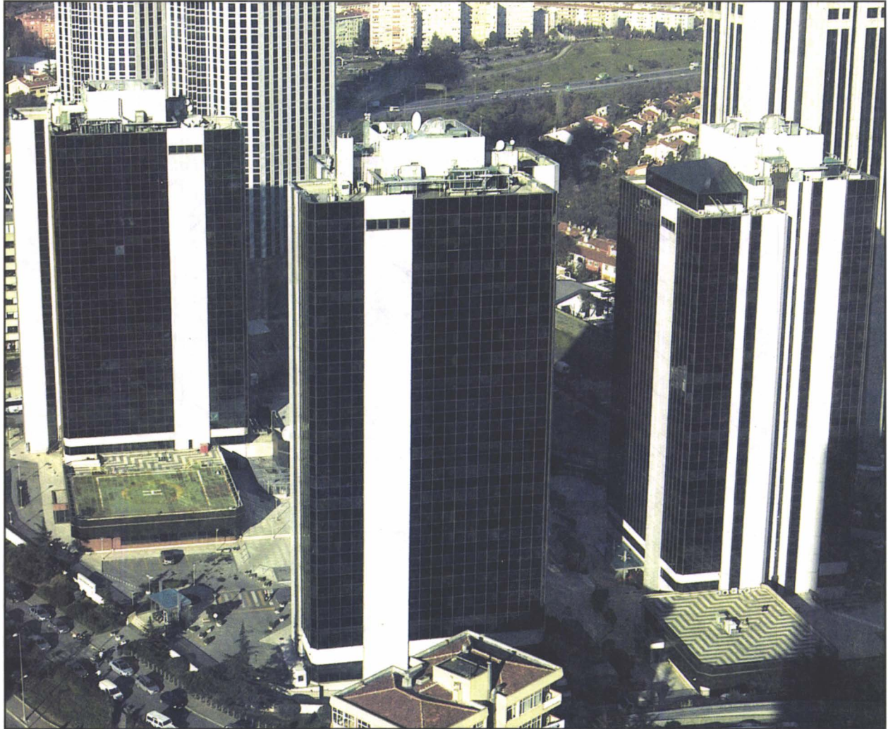
Şekil 6.20. Yapı Kredi Plaza
