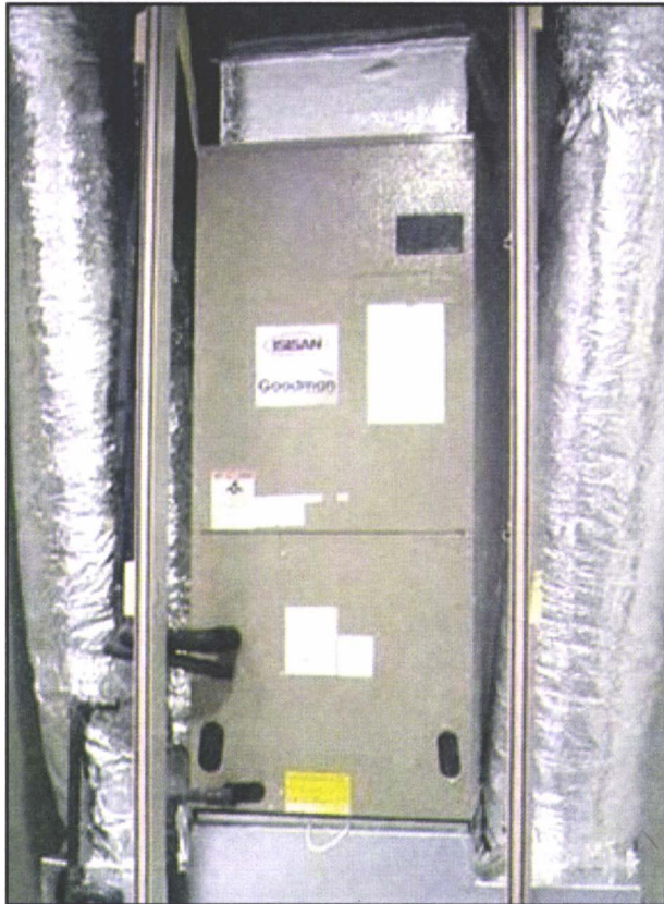
Şekil 6.44. DÖNÜŞ HAVA KANALLI UYGULAMA
