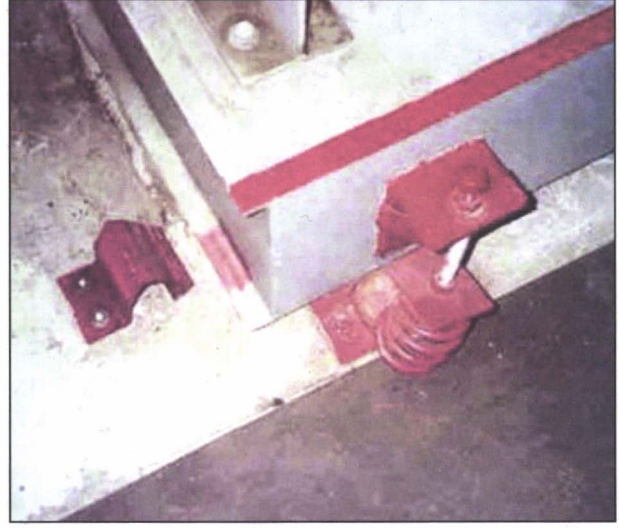
Şekil 12.9. AÇIK İZOLATÖRLERLE BİRLİKTE KULLANILMAK ÜZERE SEÇİLMİŞ ANCAK GEREĞİNDEN KÜÇÜK BOYUTLANDIRILMIŞ SİSMİK SINIRLANDIRICILAR SEBEBİYLE POMPA ŞASİSİNDE HASAR OLUŞUMU
