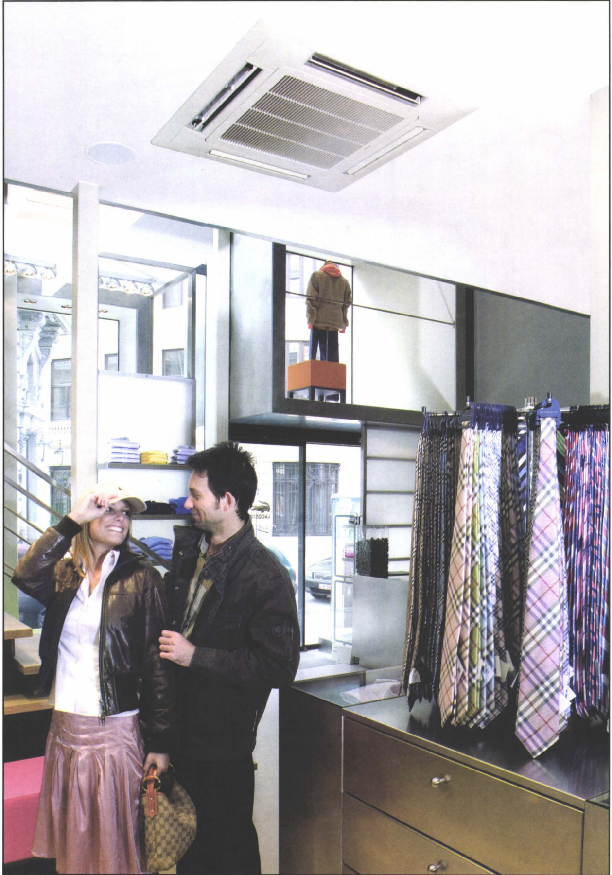
Şekil 6.57B. VRV SİSTEM KASET TİPİ İÇ ÜNİTE UYGULAMA ÖRNEĞİ
