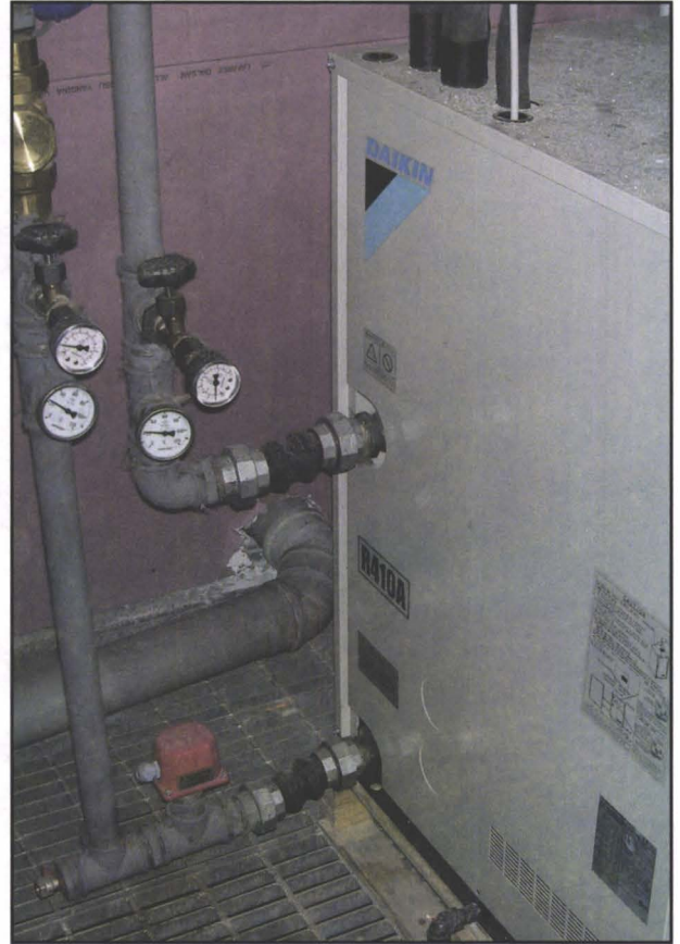
Şekil 6.95. Koza Plaza SU SOĞUTMALI VRV SİSTEM-DIŞ ÜNİTELER
