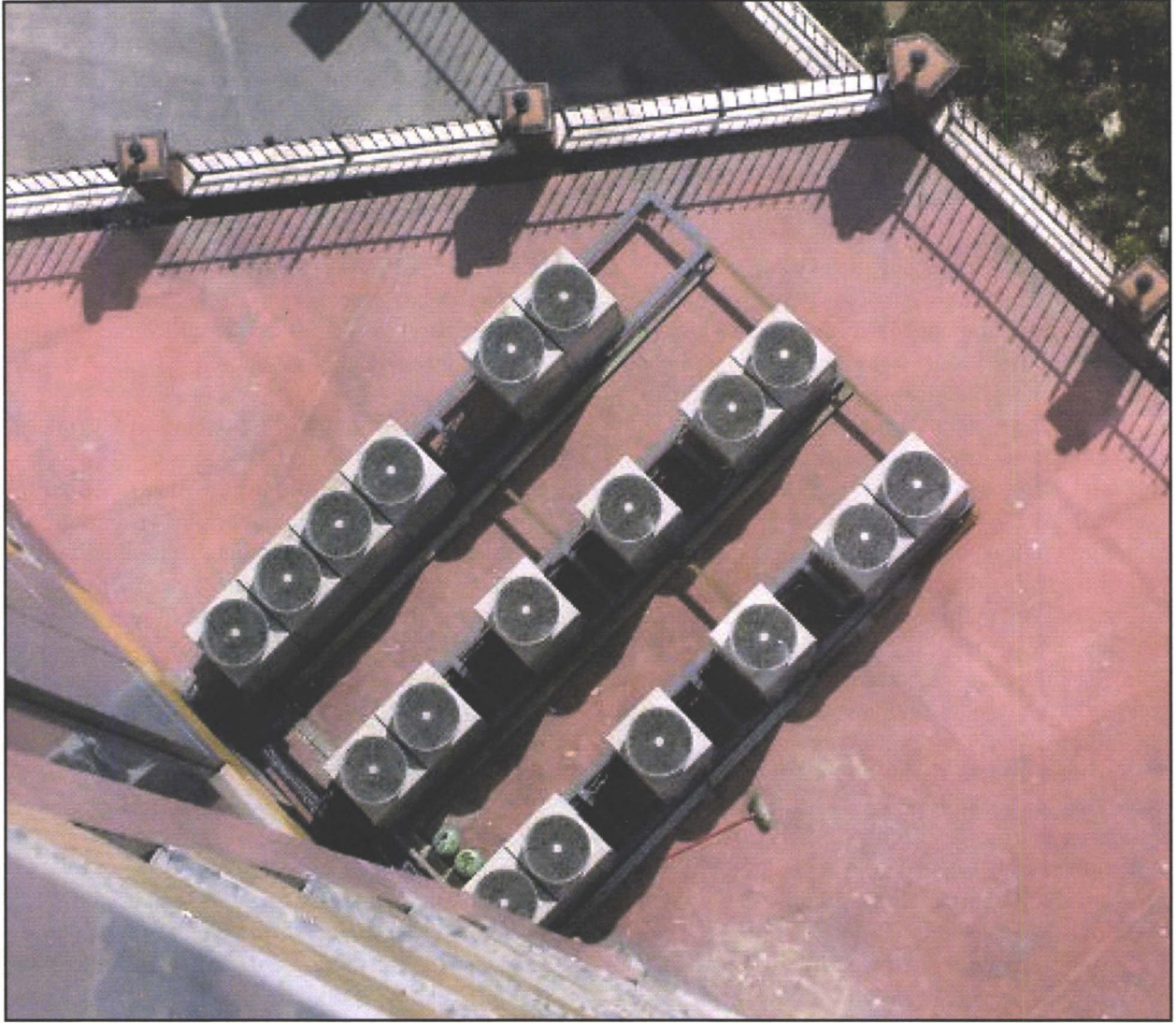
Şekil 6.79. DIŞ ÜNİTE YERLEŞİMİ
