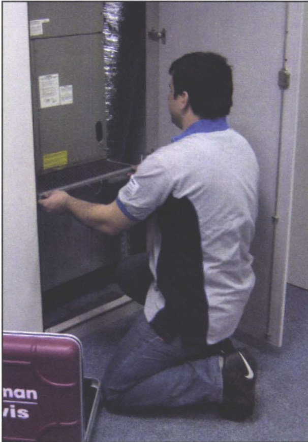
Şekil 6.46. DÖŞEMEYE MONTE EDİLEN SPLIT KLİMA İÇ ÜNİTELERİNDE BASİT VE HIZLI FİLTRE TEMİZLİĞİ YAPILABİLİR.
