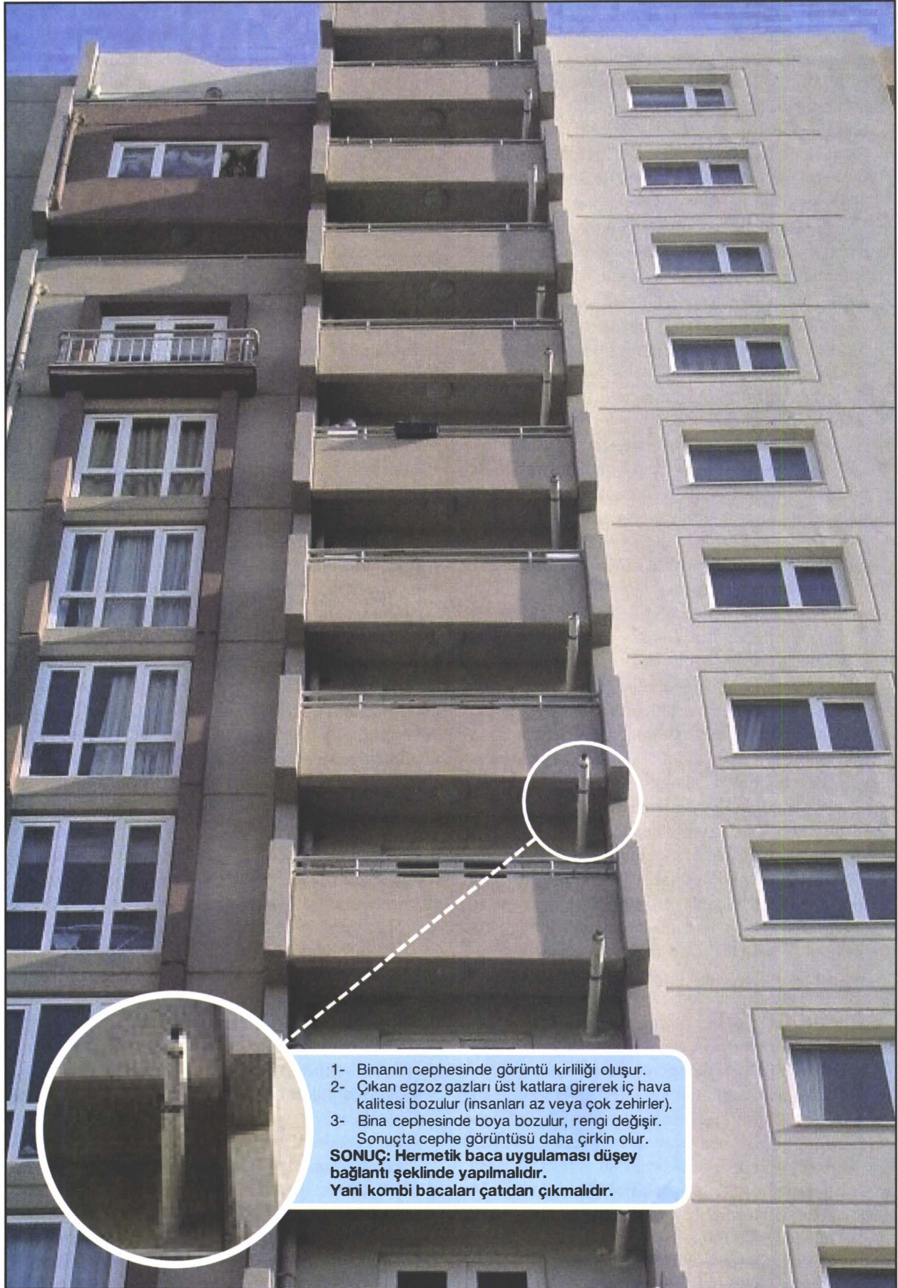
Şekil 6.99. KOMBİ BACALARI CEPHE GÖRÜNTÜSÜ
