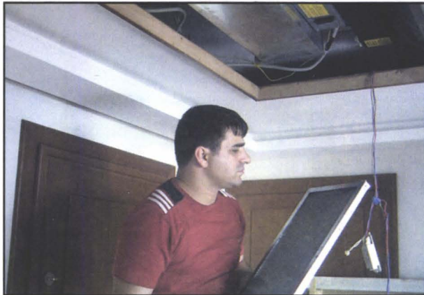
Şekil 6.47. GİZLİ TAVAN TİPİ İÇ ÜNİTEYE SERVİS HİZMETİ, YERE MONTAJA GÖRE DAHA ZOR YAPILIR. Dekorasyonda kapak detayları, servis için kolay yapılabilen boyutlarda olmalı ve kolay sökülüp takılabilmelidir.
