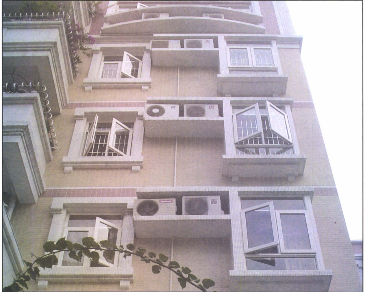
Şekil 6.103B. MİNİ SPLIT DIŞ ÜNİTE YERLEŞİMİ DÜZENLİ VE ESTETİK YERLEŞİM YAPILMIŞ, AMA SERVİS VERMEK ZOR. (SERVİS TEKNİSYENİ İÇİN ÇOK RİSKLİ. DIŞ ÜNİTELER ARASINDA DA YETERLİ SERVİS AÇIKLIĞI YOK)
